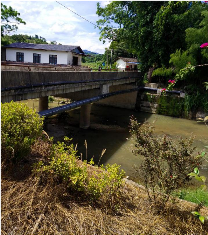
图 3.2-2 莘口镇楼源村现状污水管道
