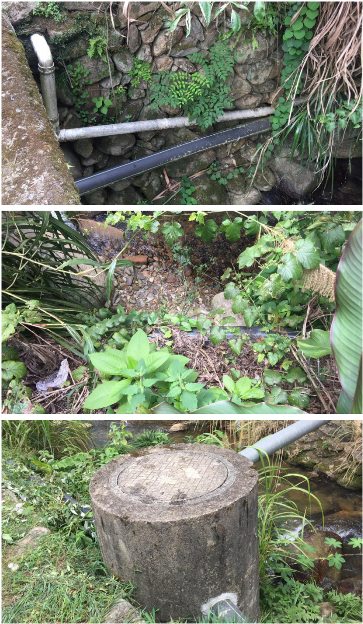
图 3.2-1 莘口镇龙泉村现状污水管道
