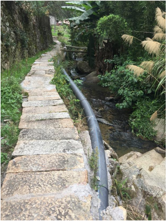
图 3.2-5 中村乡南坑村现状污水管道
