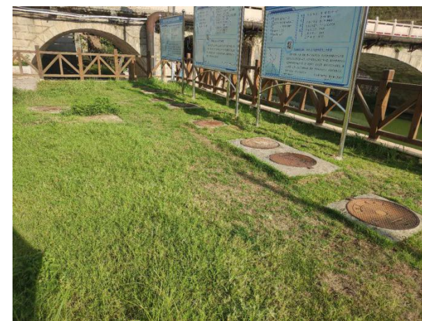
图 3.1-1 莘口镇污水处理厂现状照片
