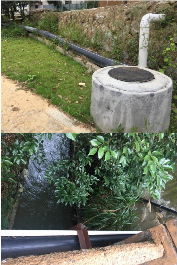
图 3.2-4 中村乡米洋村现状污水管道
